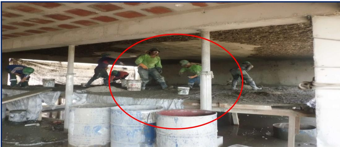
Fig.9 Se observa el proceso de tarrajeo de cielo raso en el 2do nivel del sector Administración, para lo cual se han instalado andamios para los trabajos respectivos, para estos trabajos el personal de obra contara con implementos de seguridad.
