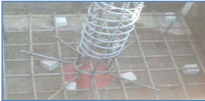
**Fig.8 Colocación de acero en columna circular**
