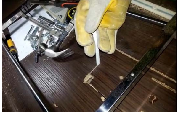
Foto 2: Cortes en el tablero inferior de apoyo durante la construcción.
